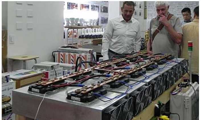
Die bei der Demo entstehende grosse Wärme wird durch Ventilatoren abgeführt.
